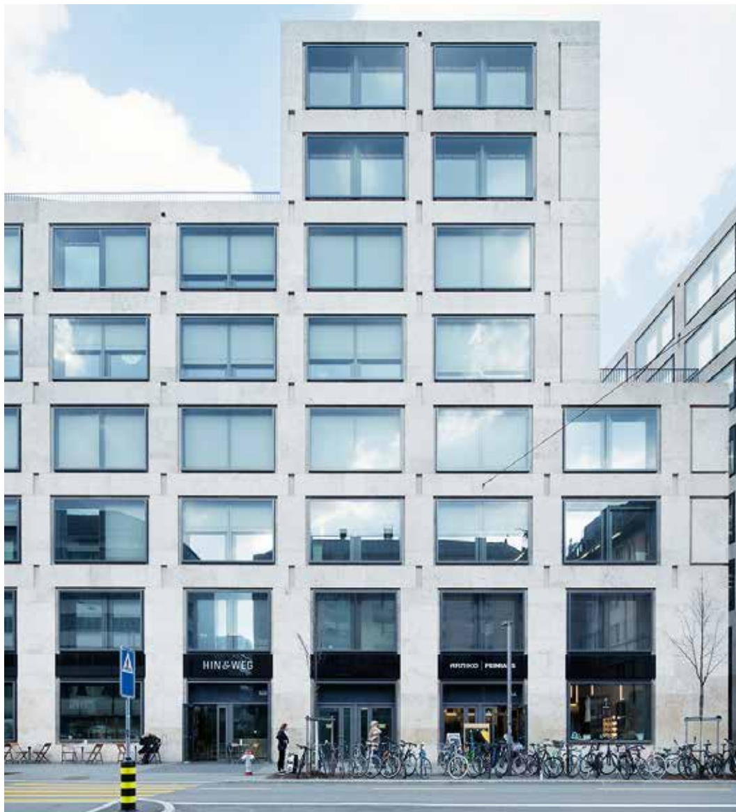
Ladenlokale in Innenstädten und Büroflächen gewinnen wieder an Attraktivität. Die Vermietungsquoten steigen, auch aufgrund der gedämpften Neubauaktivitäten. BILD: ZVG
